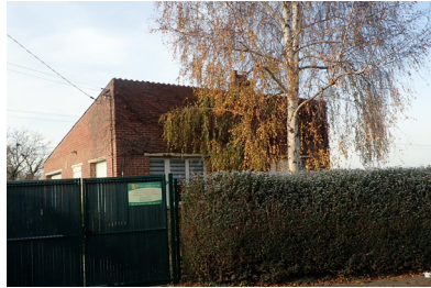
La construction en face de la zone d'étude est en brique et présente une hauteur de R
